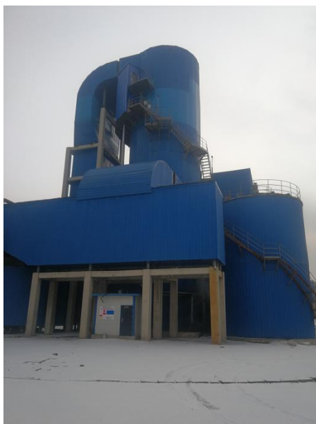
图 3.2 改造后脱硫塔（共用）
